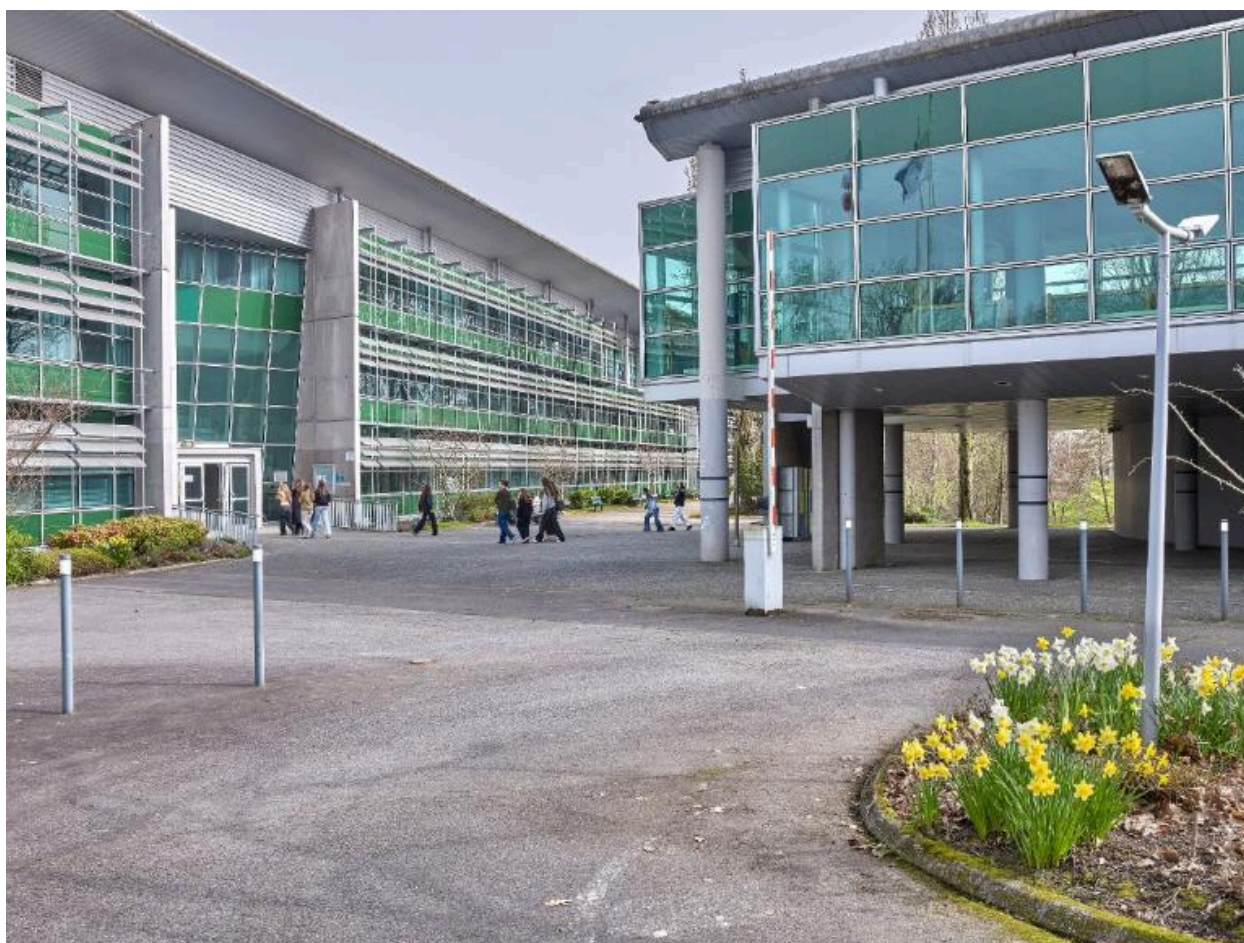
Vue d'ensemble partielle. Façade sud du bâtiment principal et angle nord-ouest de la restauration scolaire. Joël Y. Gautier, architecte, 1992.
