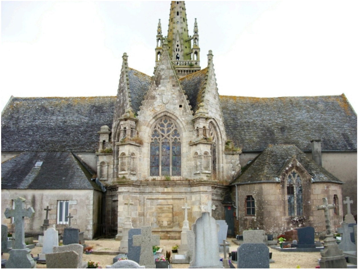
Guiclan, église paroissiale Saint-Pierre : élévation est
