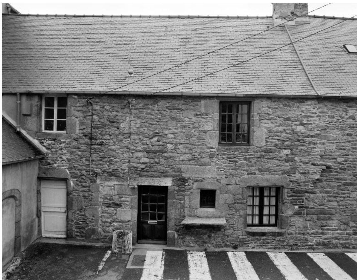
36 rue Gambetta, élévation est, vue générale
