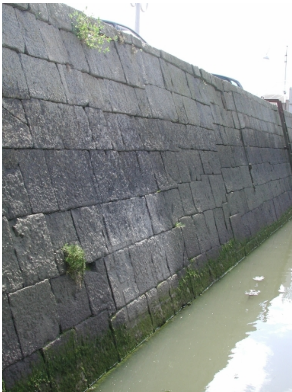
Vue de l'échelle à marée sur le mur de quai
