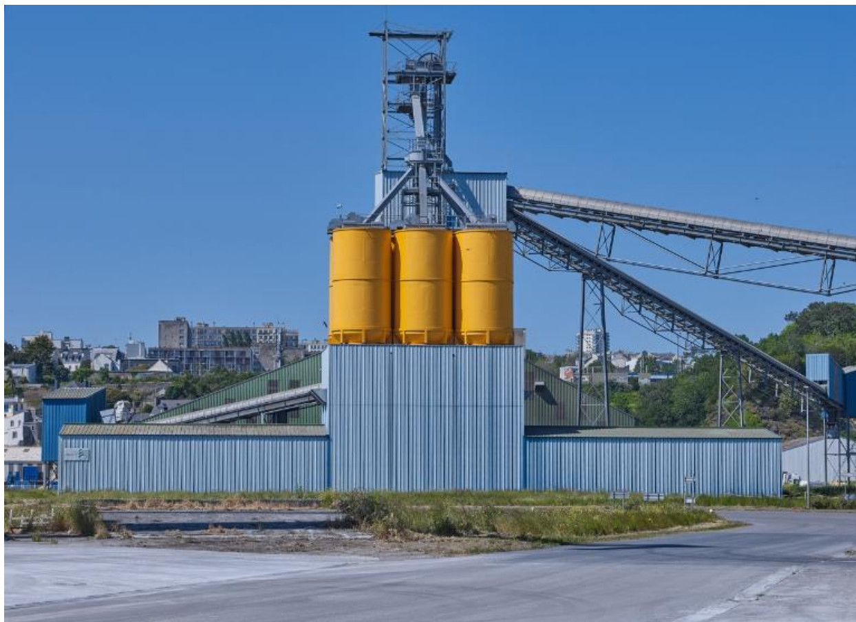
Tour de liaison entre le quai et le magasin T
