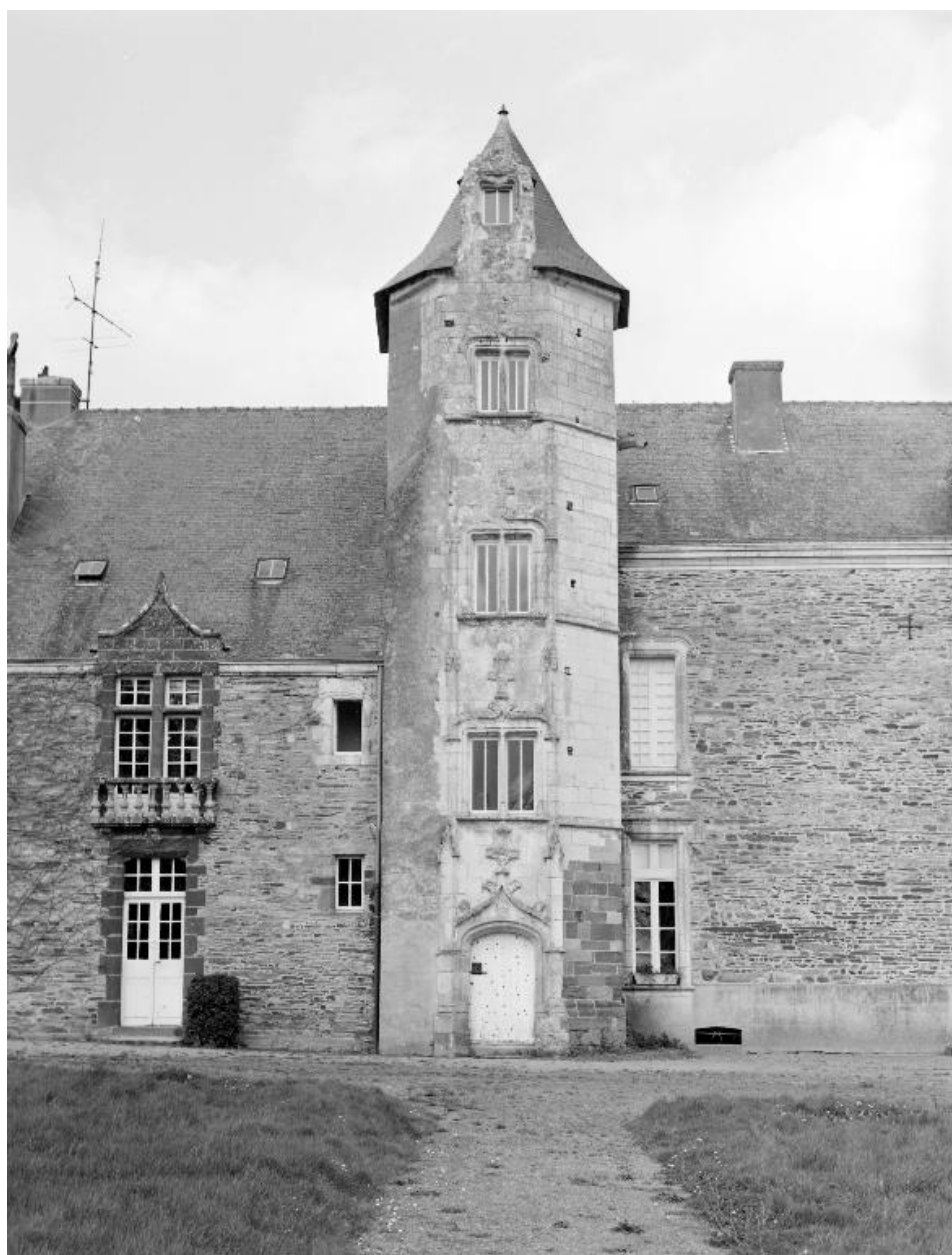
Élévation sud : vue générale de la tour d'escalier
