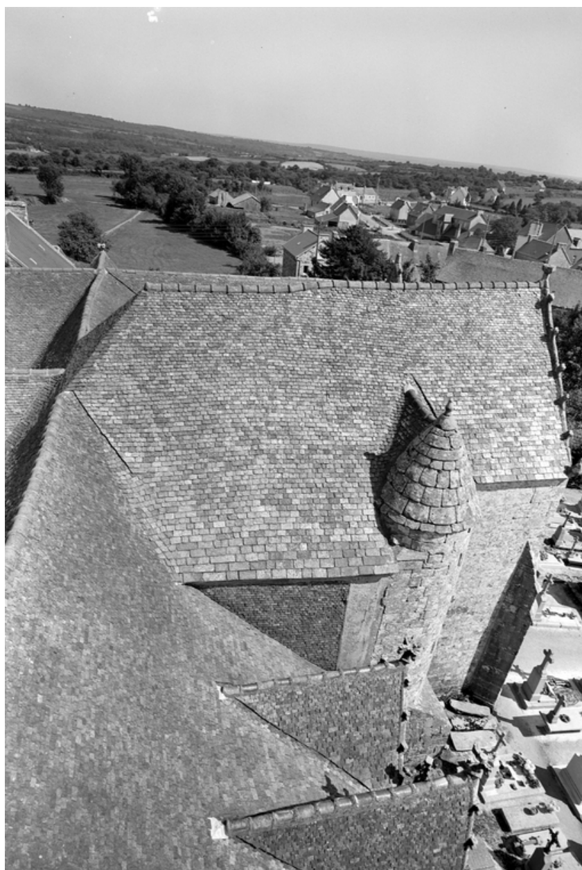
Toitures de la nef et du porche sud
