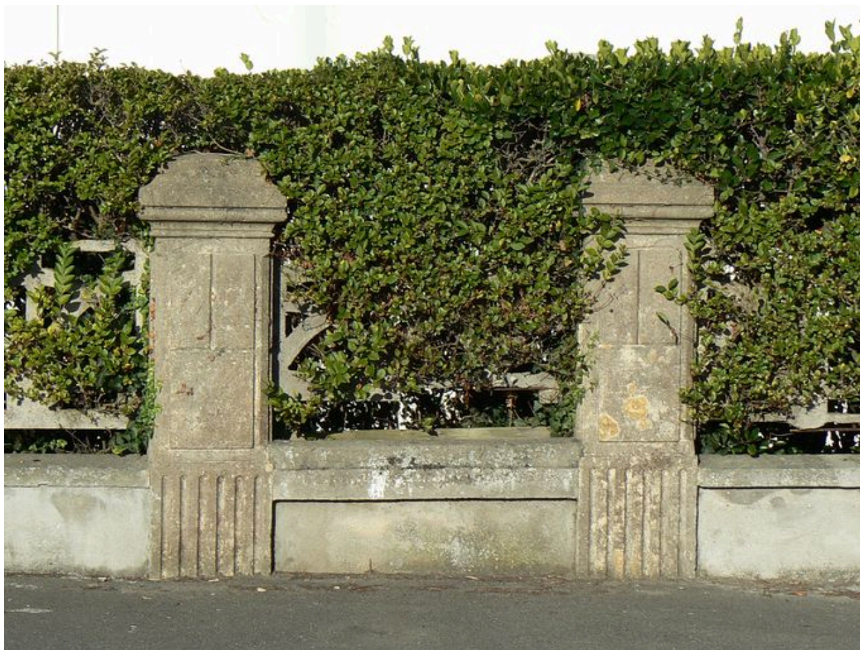
Piliers de clôture de la villa 3 boulevard des Plages
