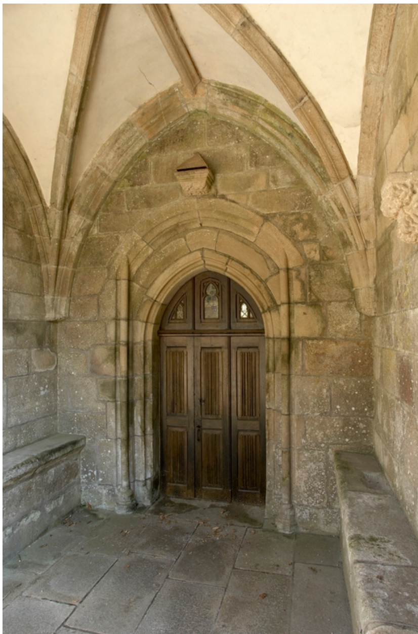
Porche sud, vue générale intérieure
