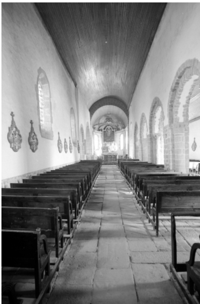
Intérieur : vue générale vers le chœur.
