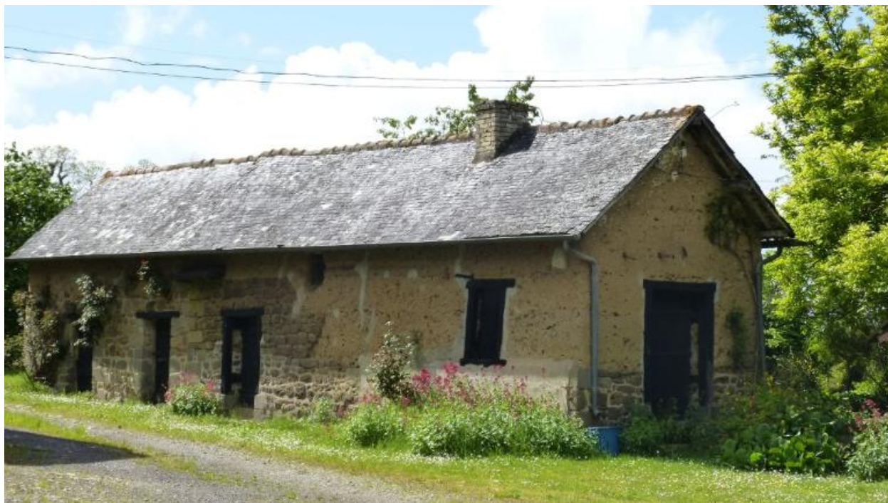
Vue générale sud est de la porcherie
