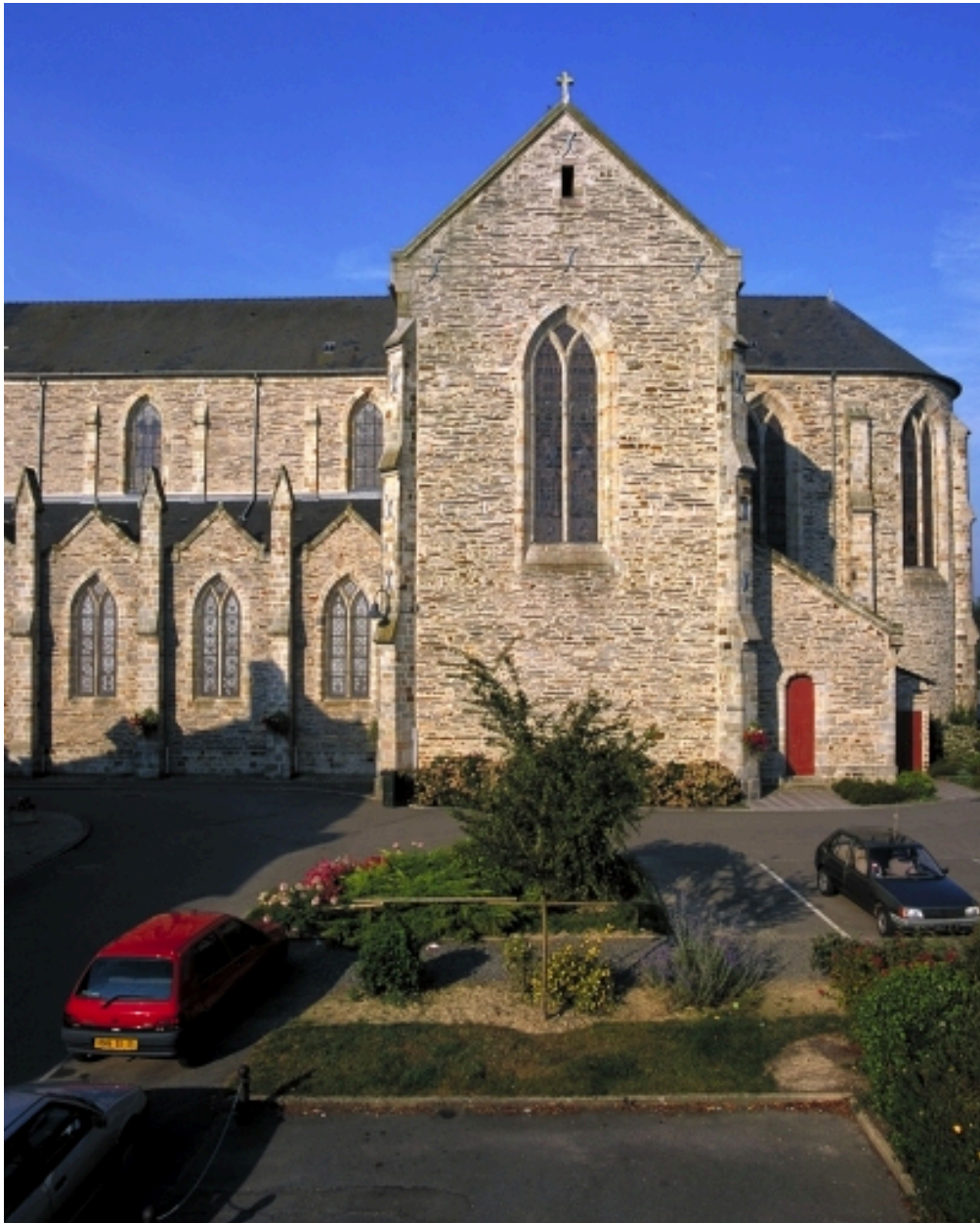
Le transept, croisillon droit : vue générale est
