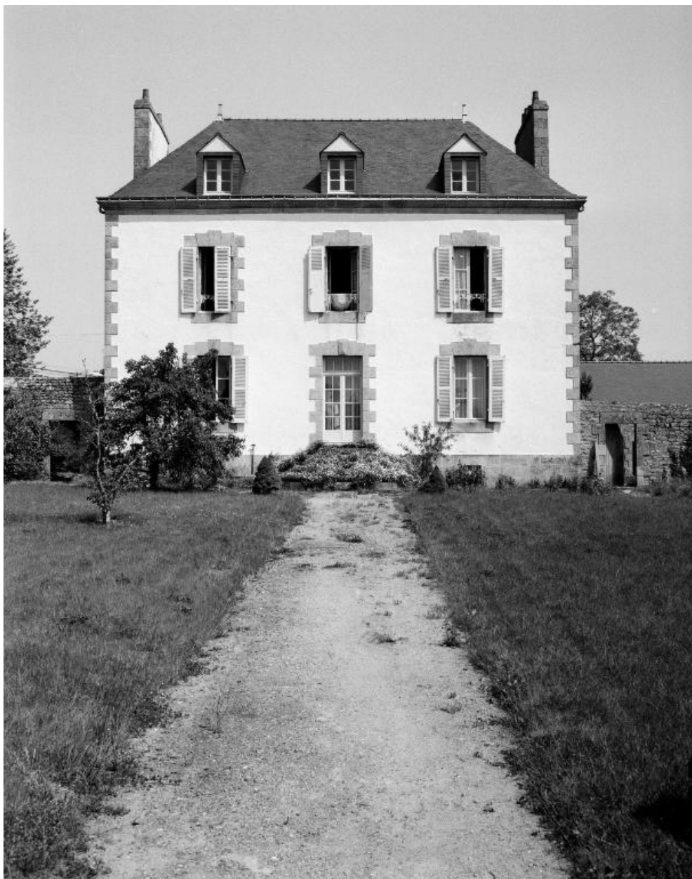
Vue de situation prise de l'est
