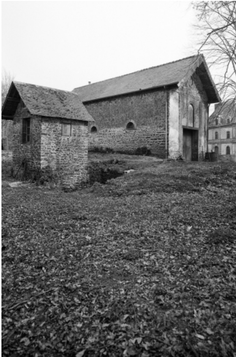
Dépendances, vue générale nord.
