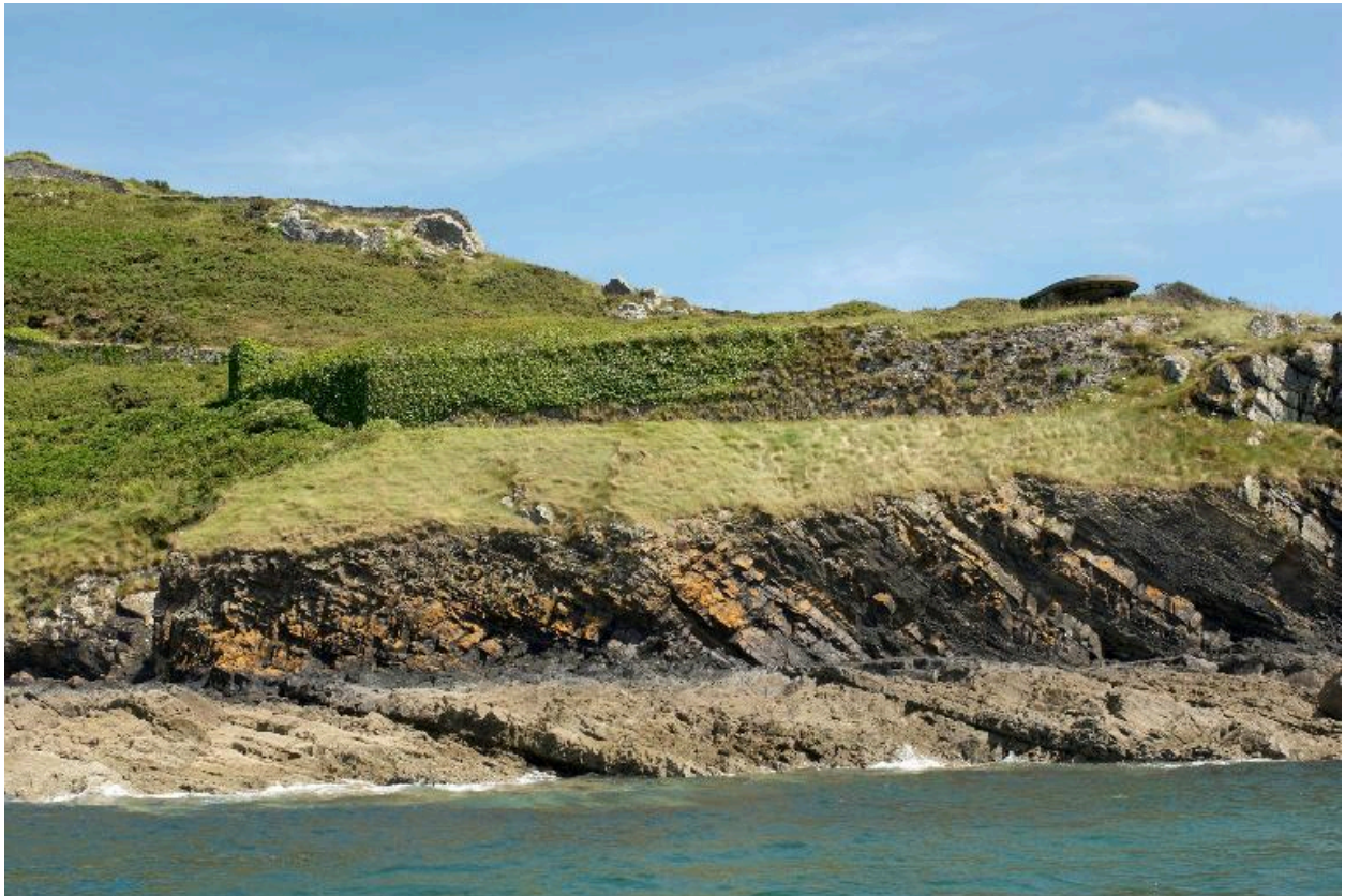
Vue nord-ouest du fort du Corbeau depuis la mer : mur de soutènement du parapet de la batterie basse (état en 2009). A droite : dalle de couverture de l'abri de combat du poste photo-électrique (projecteur de 90 cm de diamètre)
