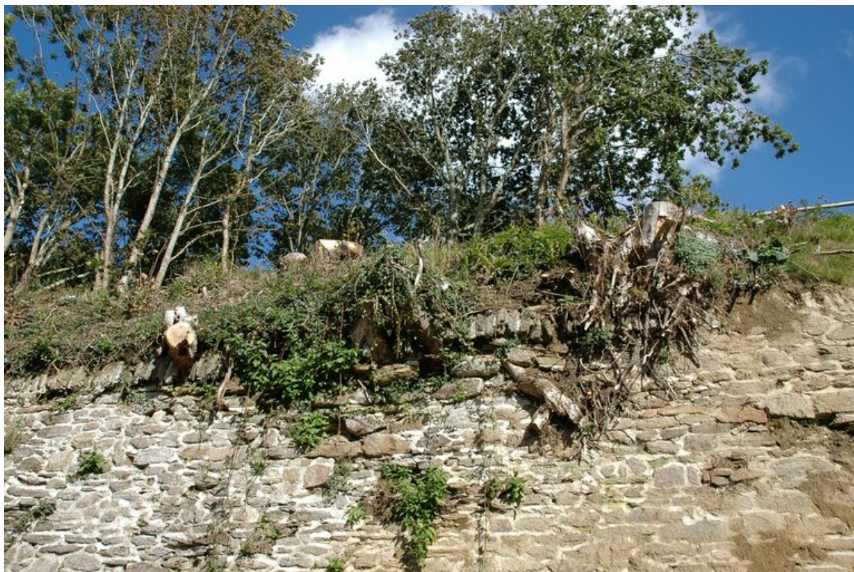
Vue de l'ouvrage à cornes de Quéliverzan
