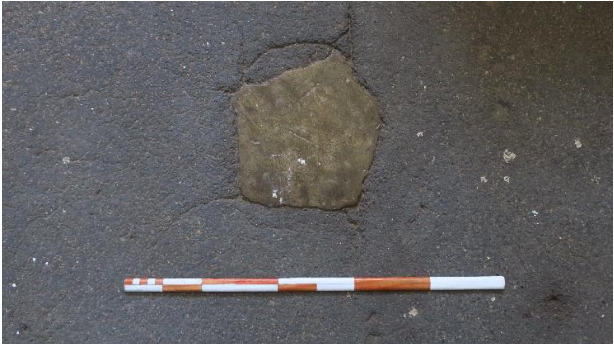
Île-d'Houat, batterie du Béniguet, corps de garde crénelé, sol en bitume et vestige de plot de poteau support de hamacs.
