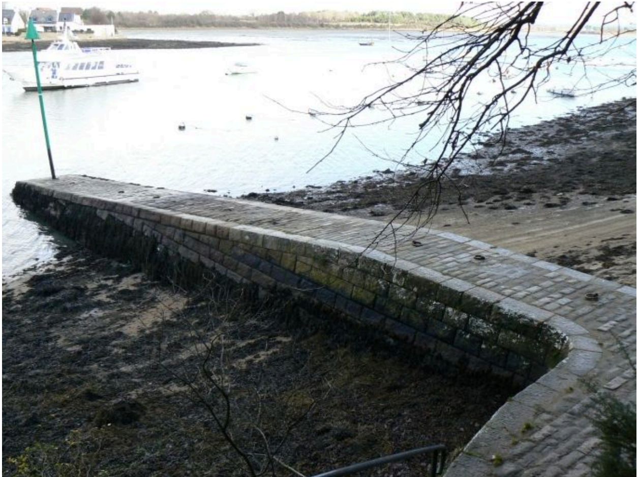
Vue générale de la cale de passage de Barrarac'h
