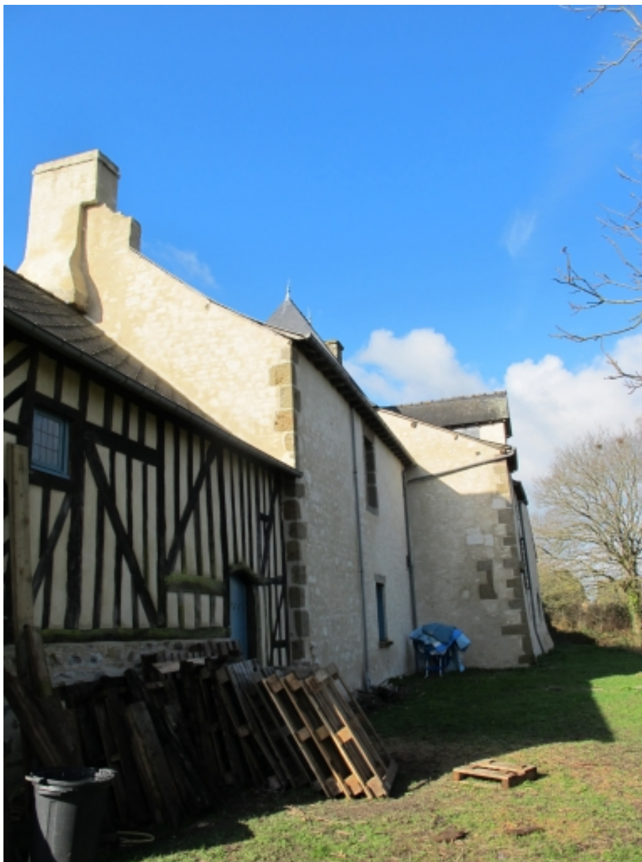
Façade nord du logis
