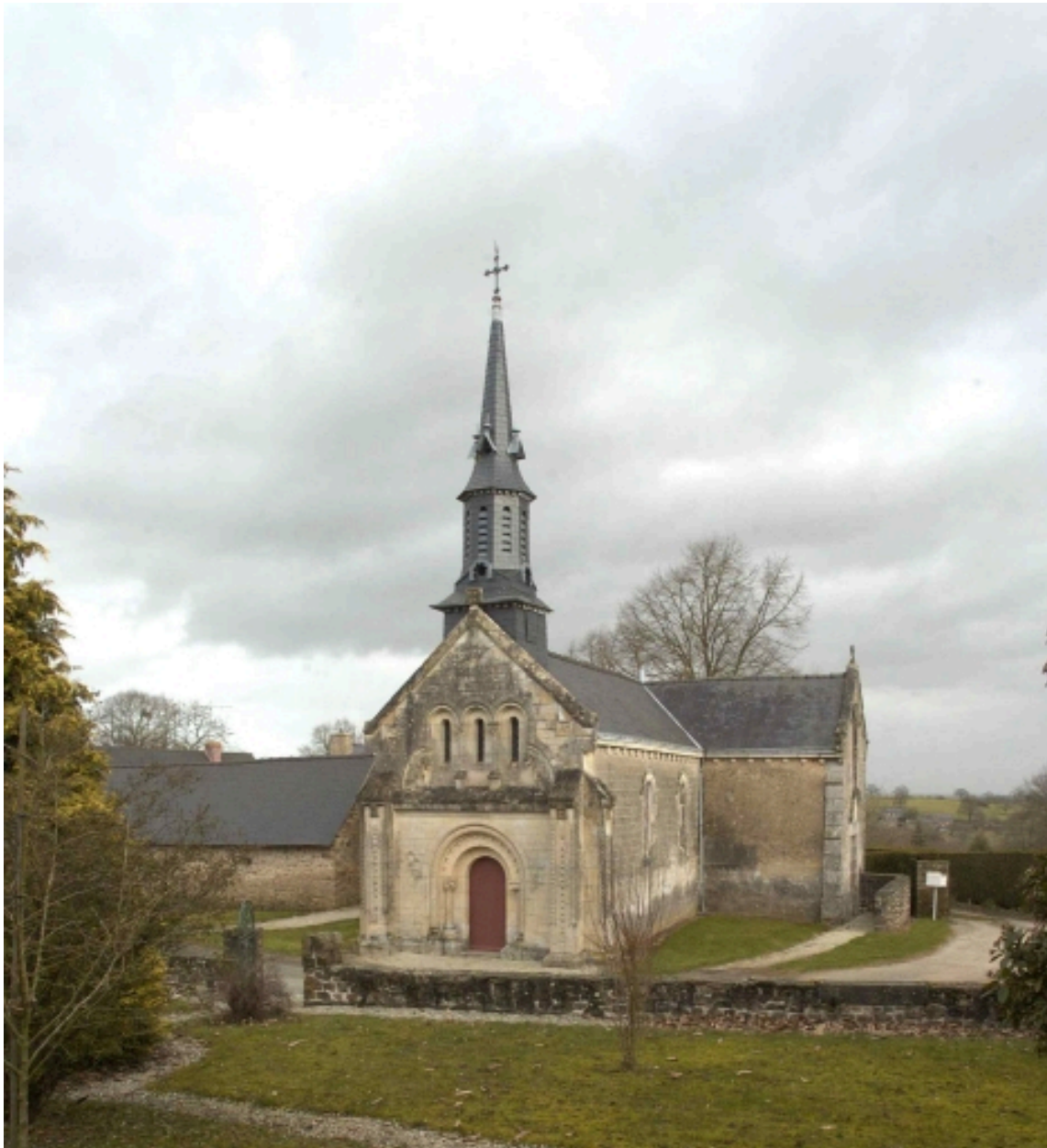
Vue générale de situation
