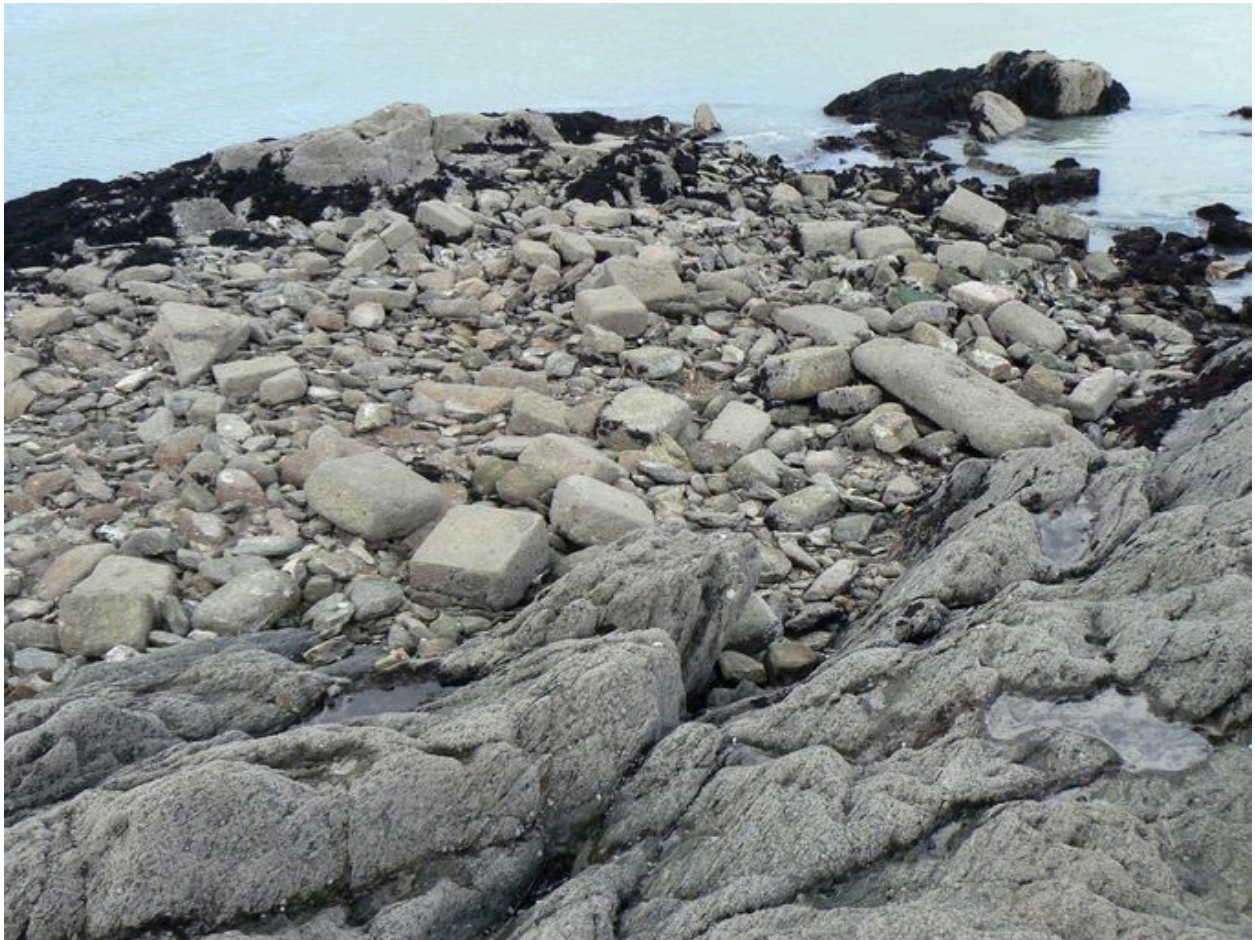
Pierres subsistant au pied du môle de la Grande Vache depuis sa réfection
