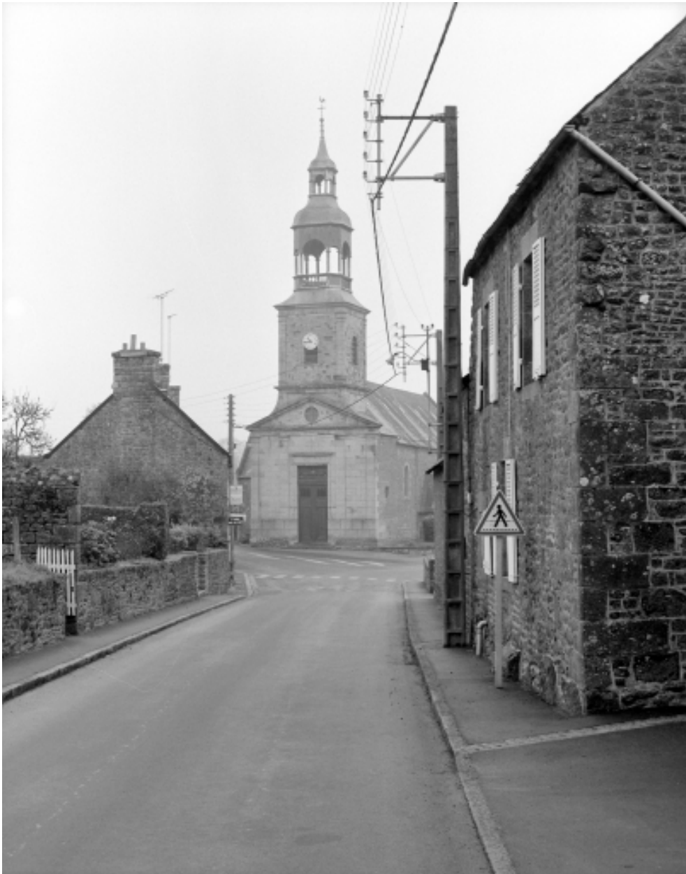
Elévation Ouest, clocher : vue générale
