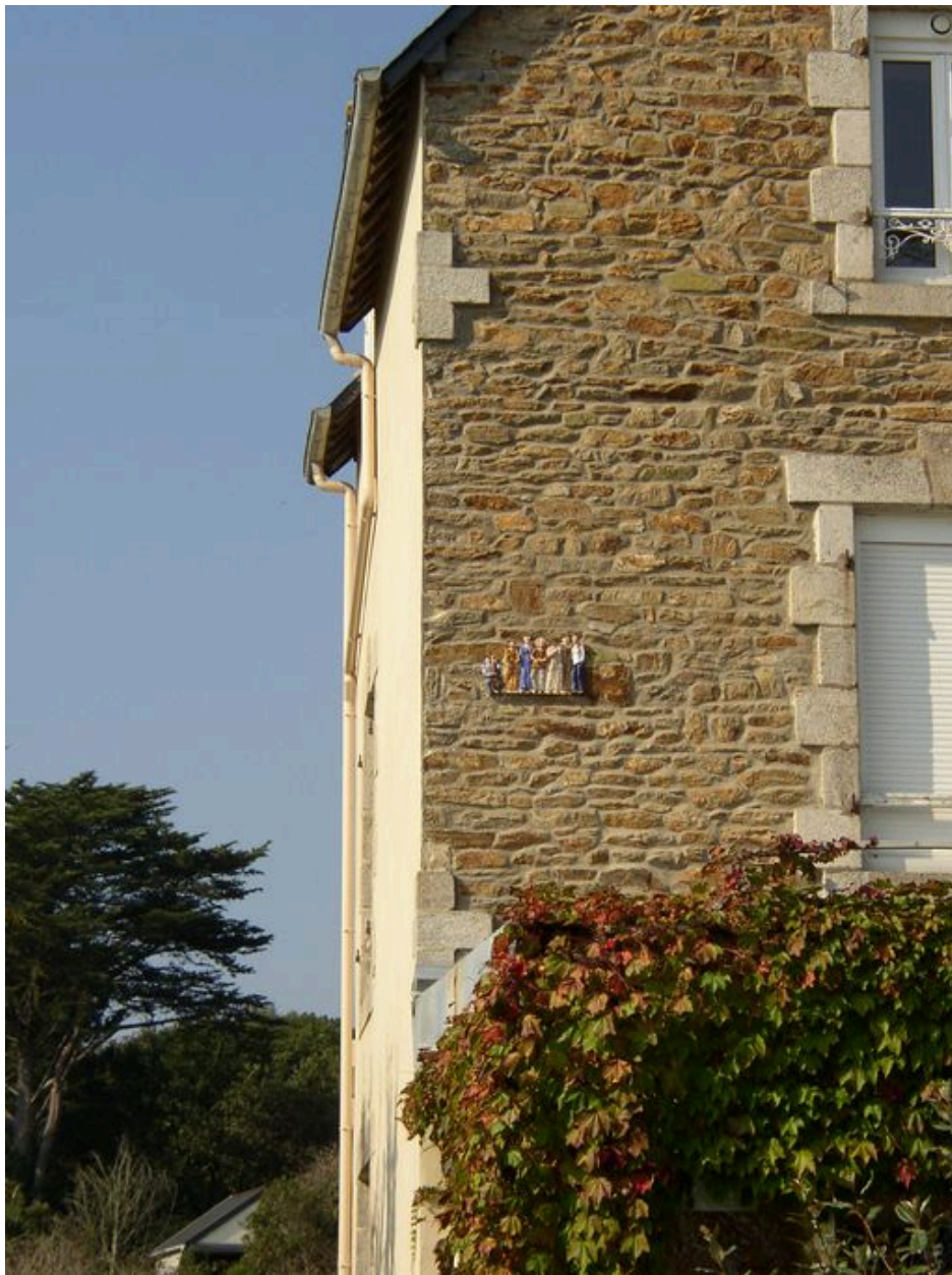
Elément décoratif du pignon formant façade
