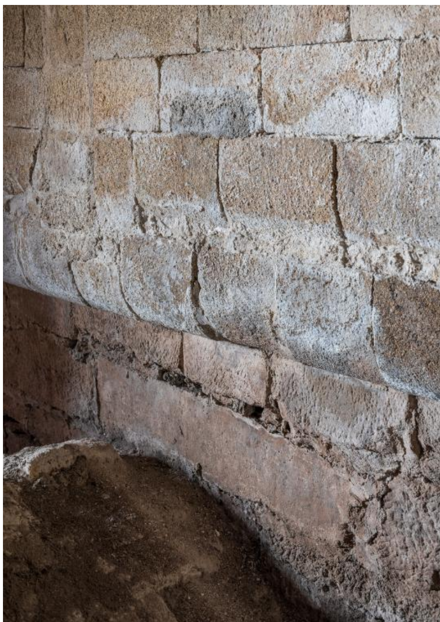
Détail de la maçonnerie en encorbellement d'un des pignons de l'abside à trois pans.
