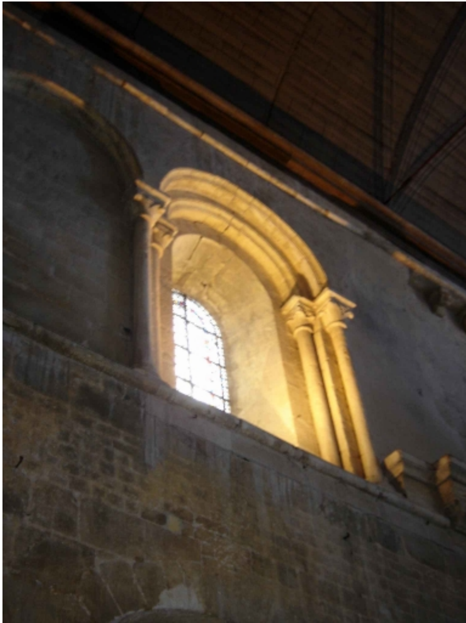
Élévation intérieure Sud : détail d'une baie du registre supérieur
