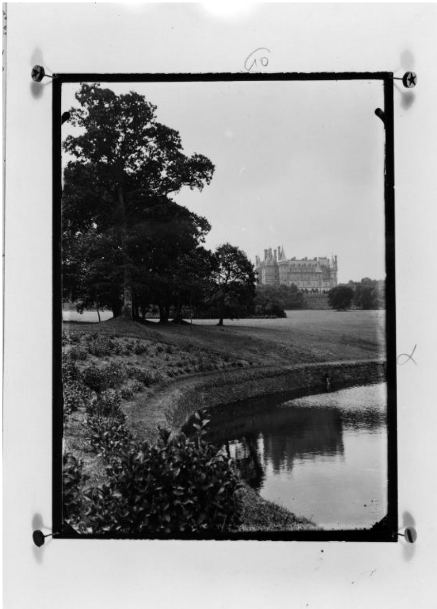
Reproduction - Vue de situation prise du nord-est (Archives départementales du Finistère)
