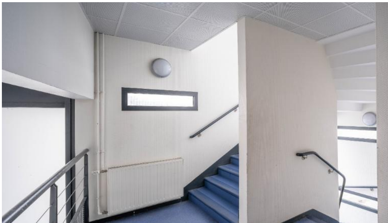
Internat : escalier dans #uvre. Agence Déesse 23, architecte, 2006.
