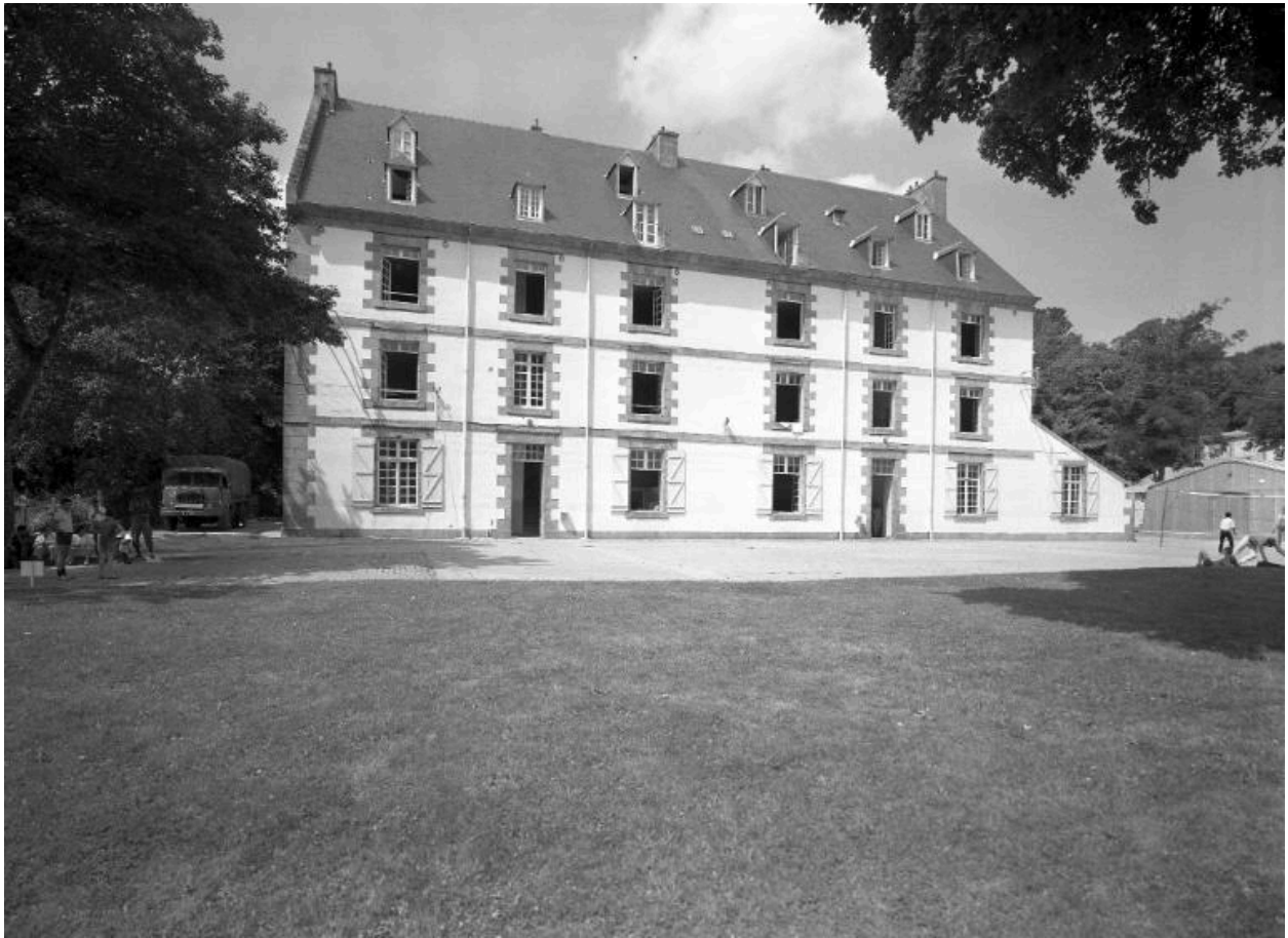
Vue générale de la caserne de Sourdis depuis le sud: élévation principale orientée vers l'est et la rade de Brest (état en 1971)
