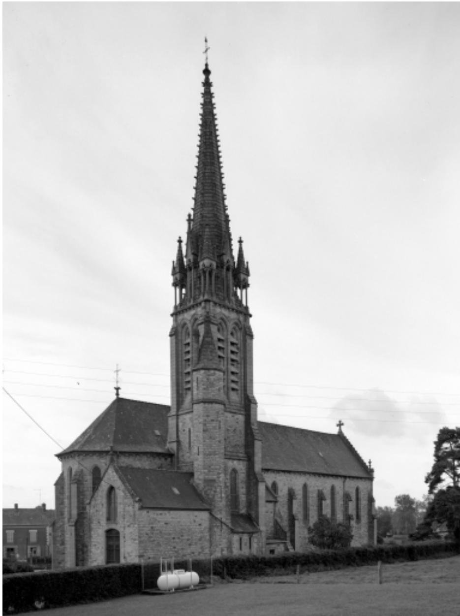
Vue générale nord-est.
