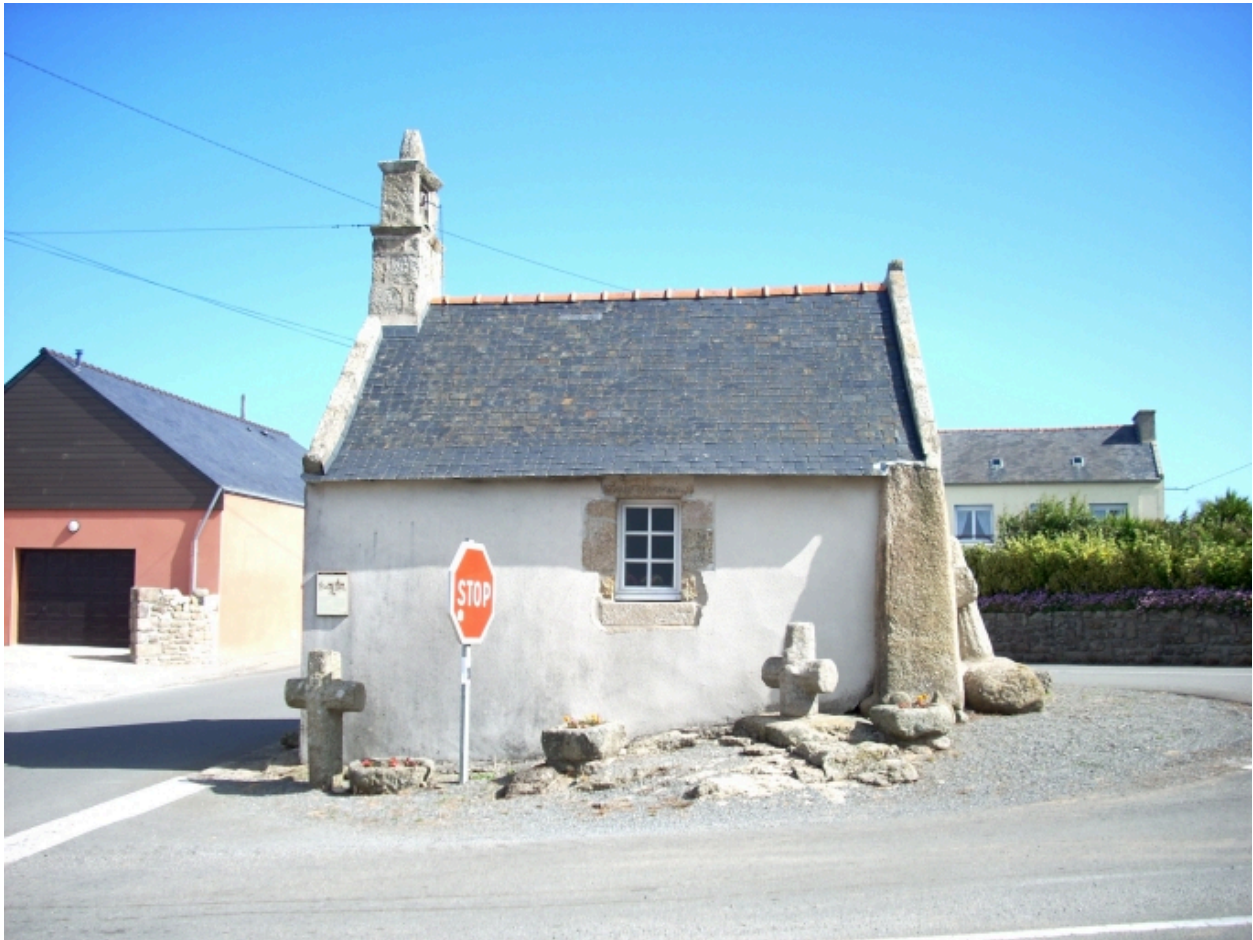
Kerlouan, chapelle Notre-Dame du Croazou : élévation sud
