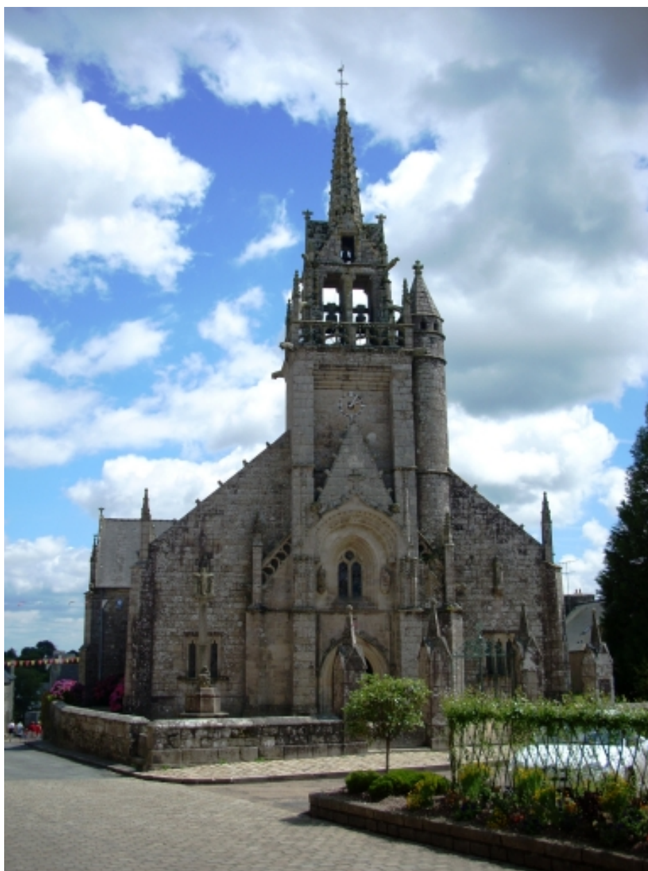
Guerlesquin, église paroissiale Saint-Thénéan : vue générale ouest
