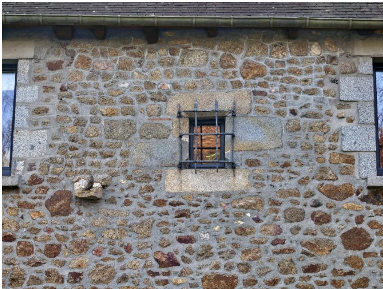
Façade nord. Fenêtre de la chambre protégée par une grille, pierre d'évacuation du lave-main
