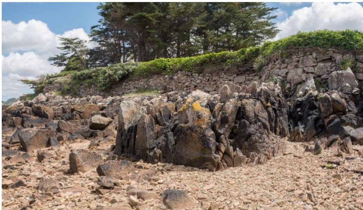
Vue d'un mur de soutènement de forme sinusoïdale, surplombant un affleurement rocheux, à côté du port de Buguélès
