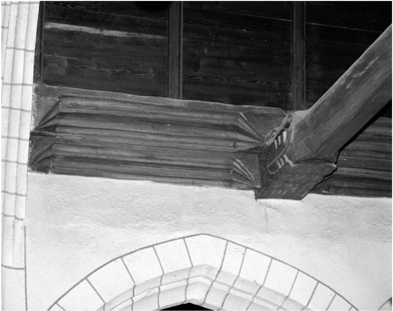
Intérieur, chapelle sud n°2, sablières et entrait : vue générale
