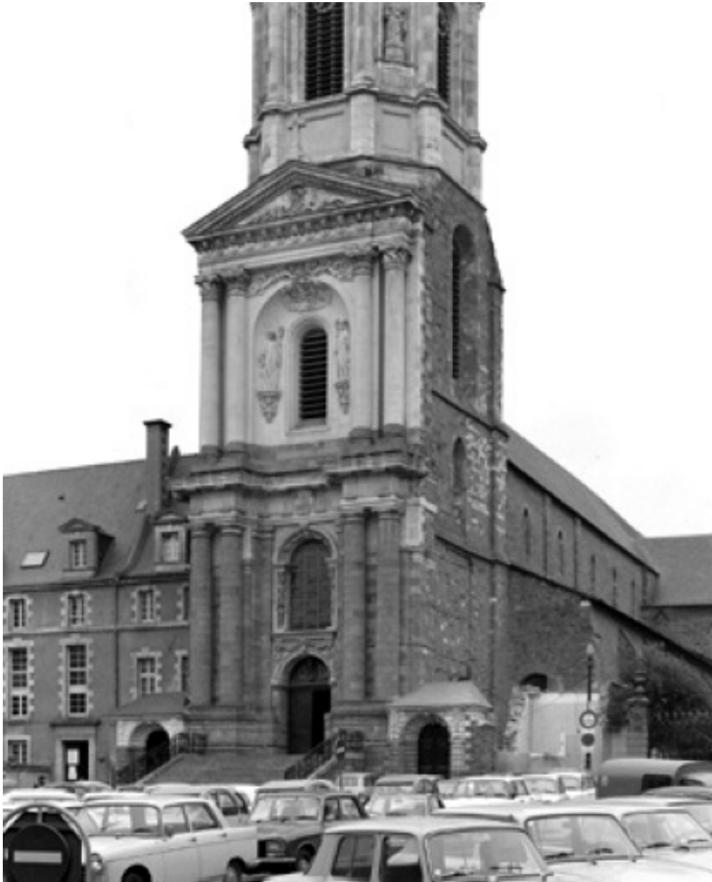
Vue générale de l'élévation ouest
