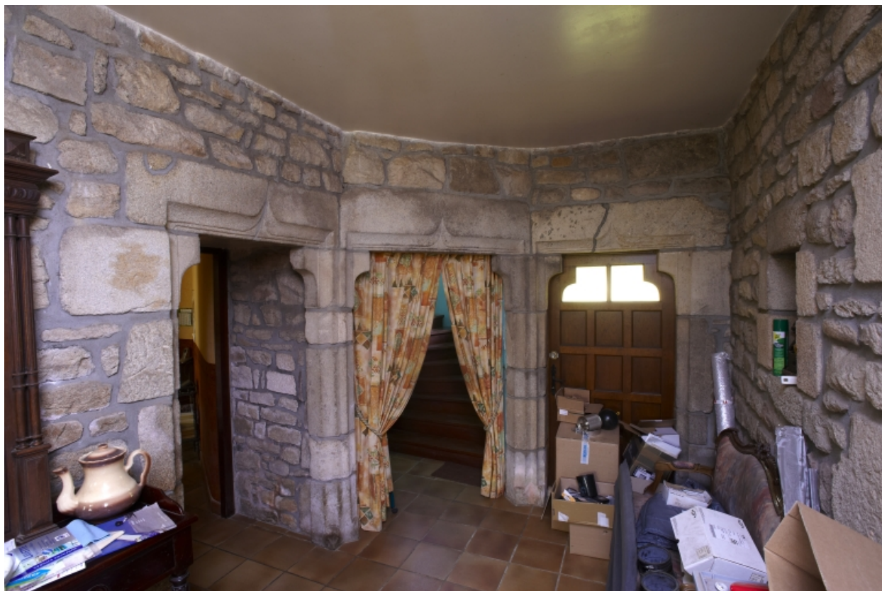
Entrée, portes à linteau sur corbelet
