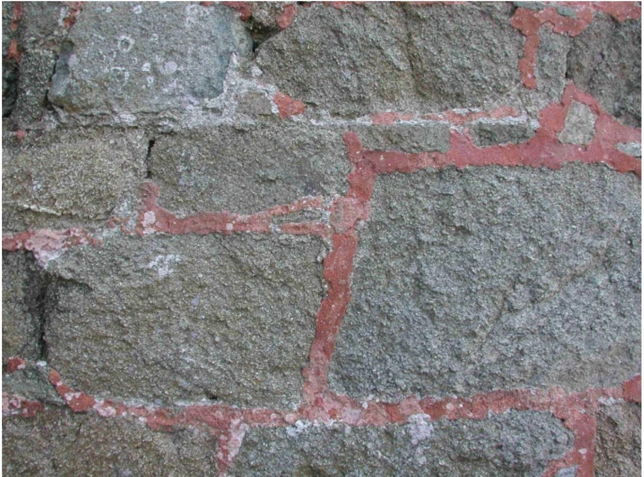
Détail des joints de la redoute refaits traditionnellement avec de la poudre de brique
