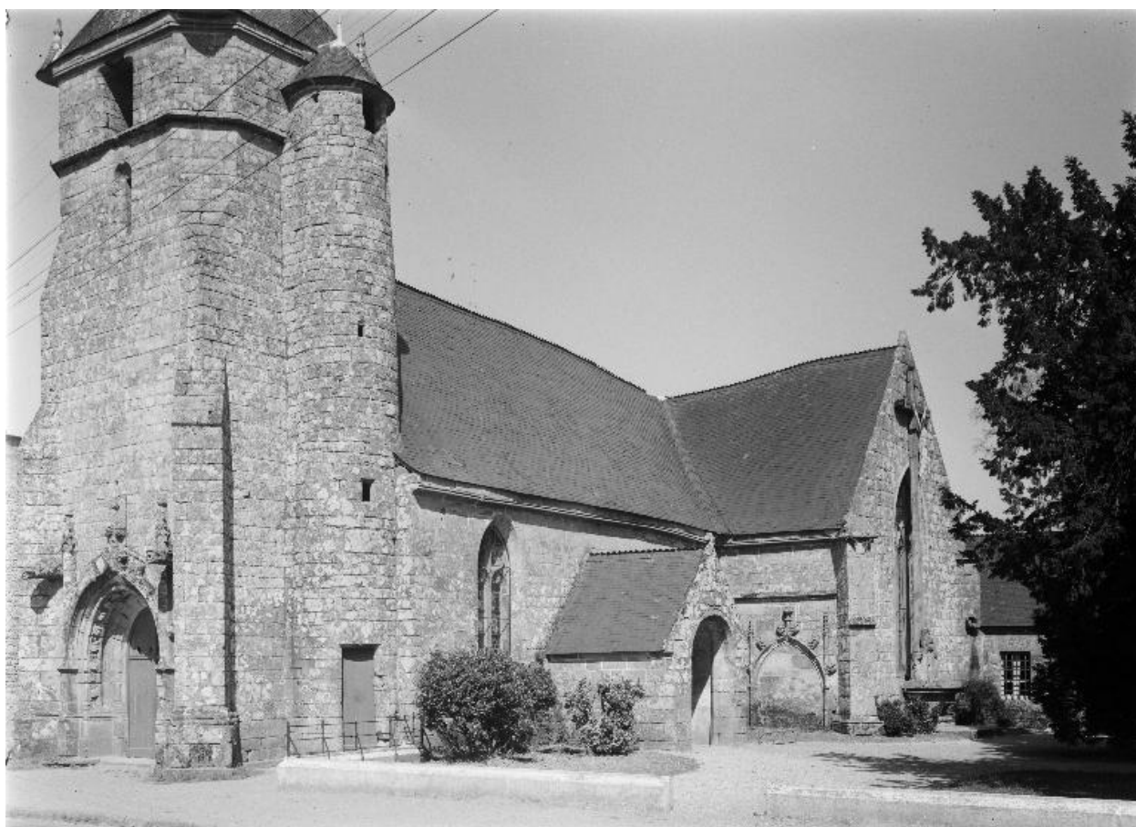
Vue d'ensemble de la façade sud
