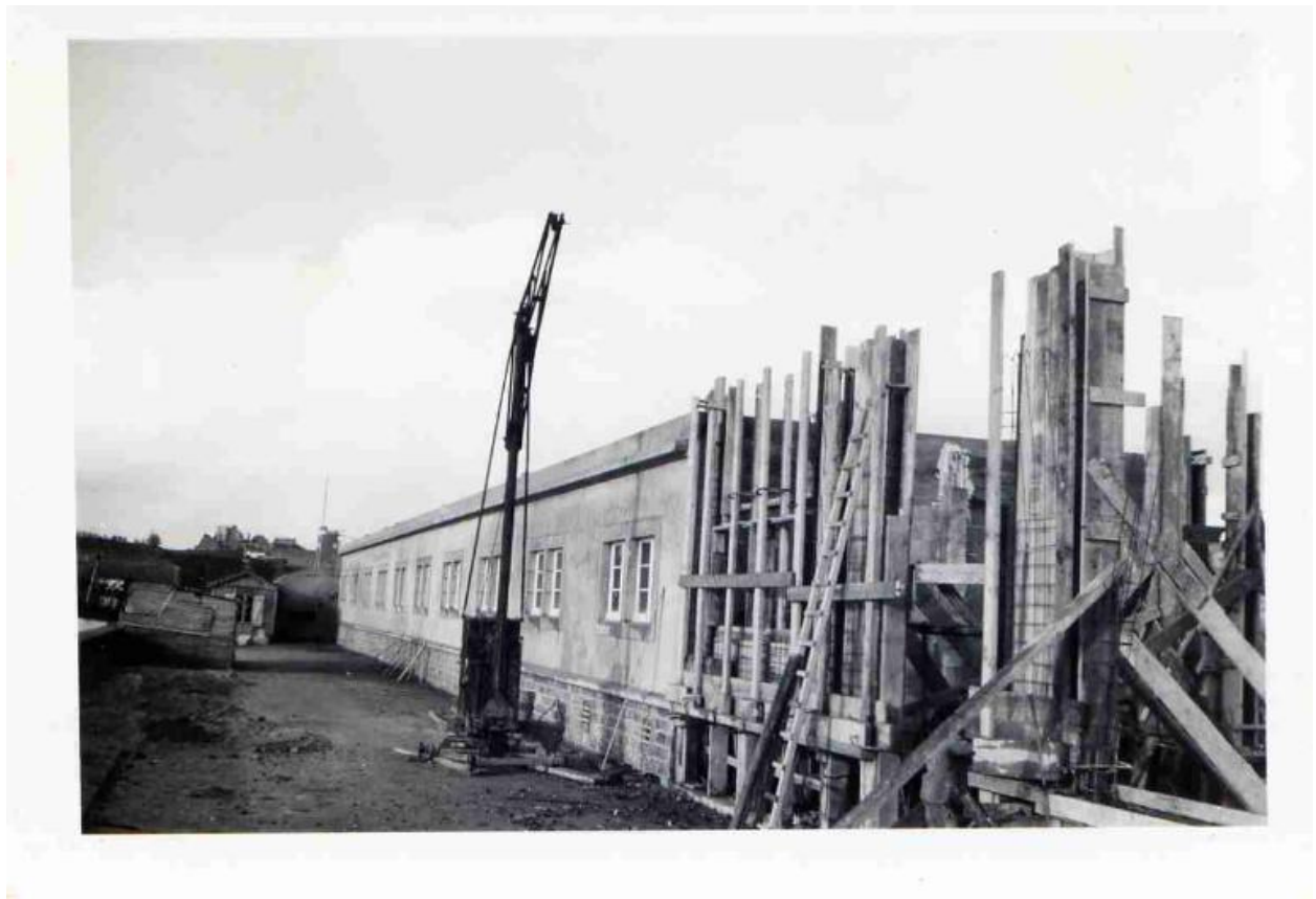
Bâtiment de pilotage en cours de construction (12/1949)
