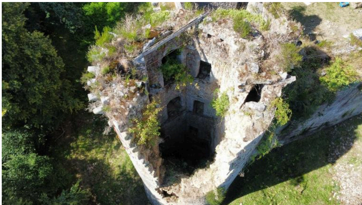
Vue aérienne oblique : tour orientale. Elle est couronnée de consoles de mâchicoulis
