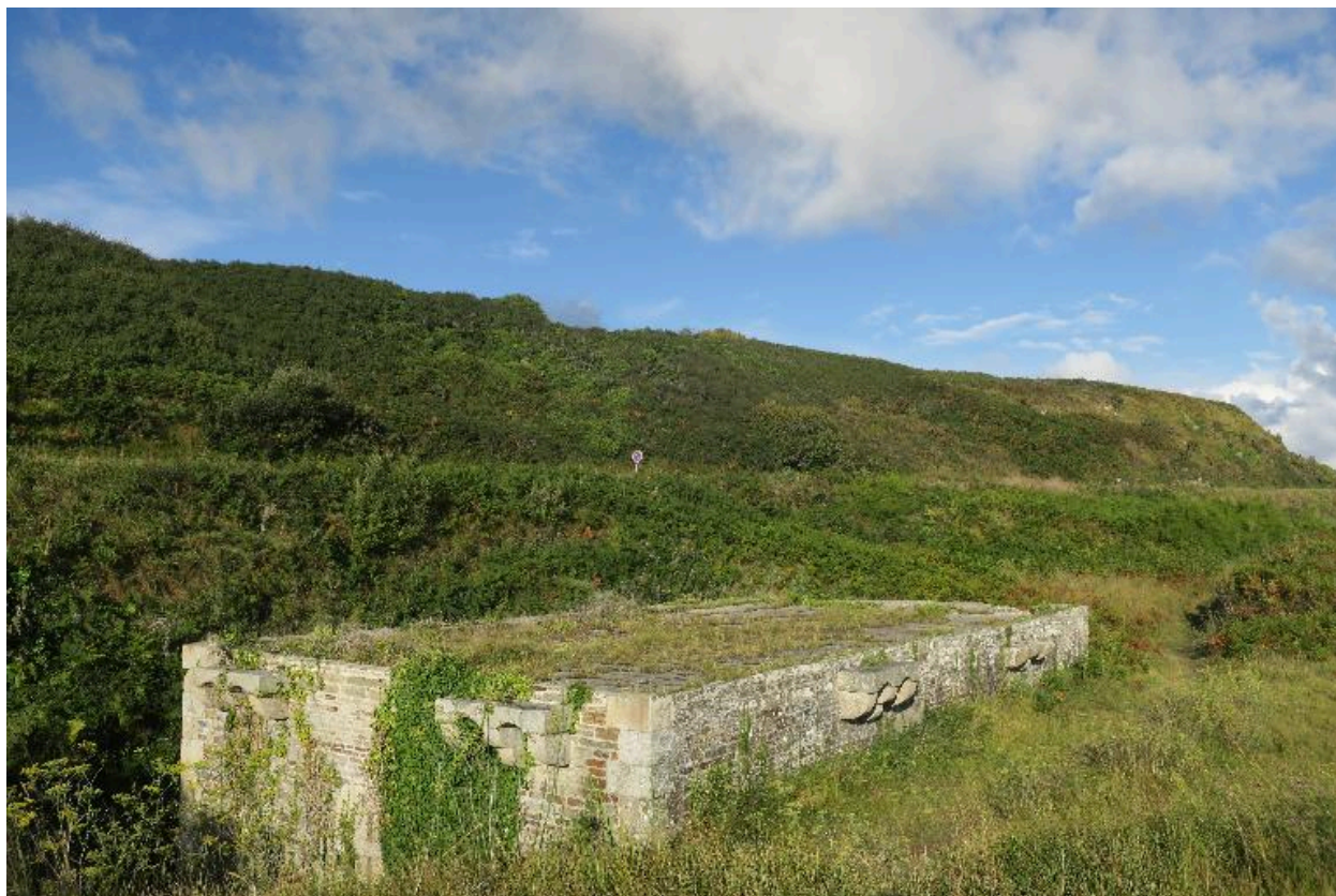
Locmaria, Grands Sables, batterie de La Ferrière, corps de garde crénelé, angle nord-est.
