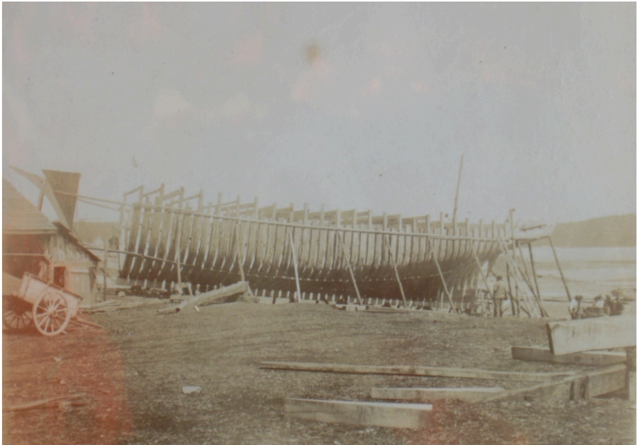
Vue d'un navire de grande pêche en construction, devant l'étang de Poulafret, 1er quart 20ème siècle (collection particulière)
