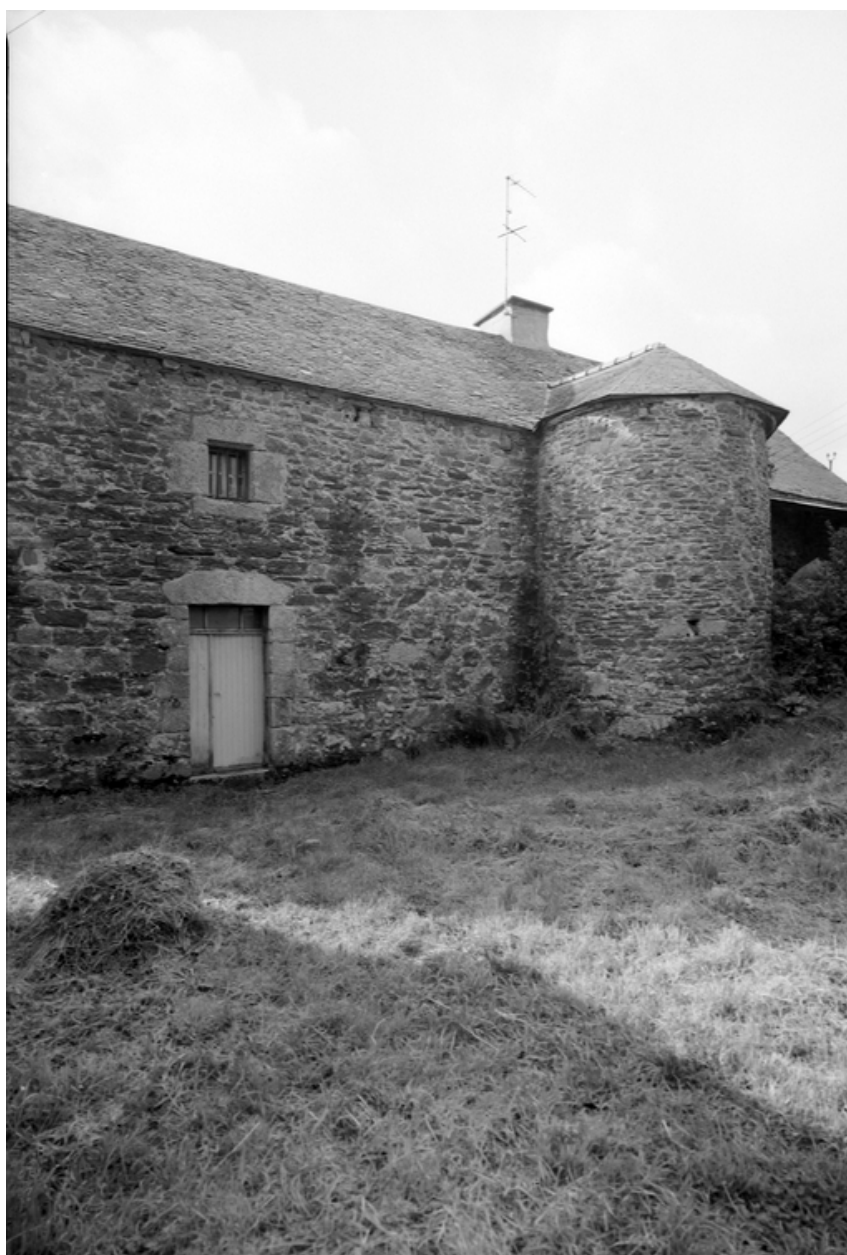
Vue de la façade nord
