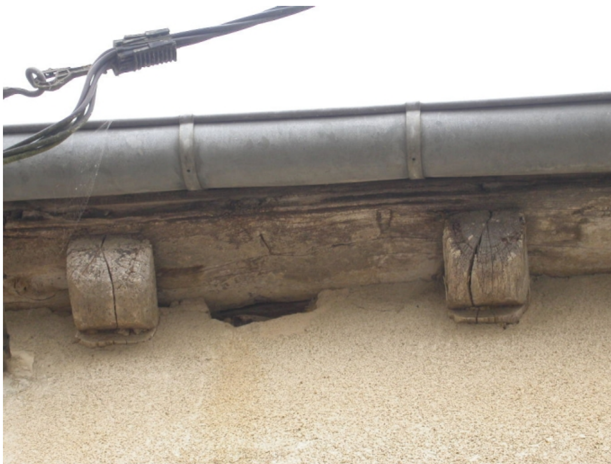
Détail de la corniche de la partie est
