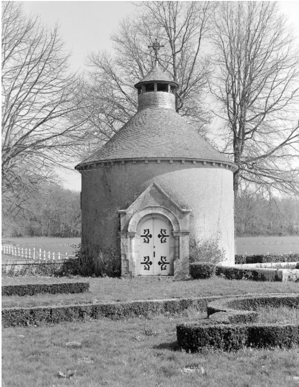
Château : la chapelle (état en 1984)
