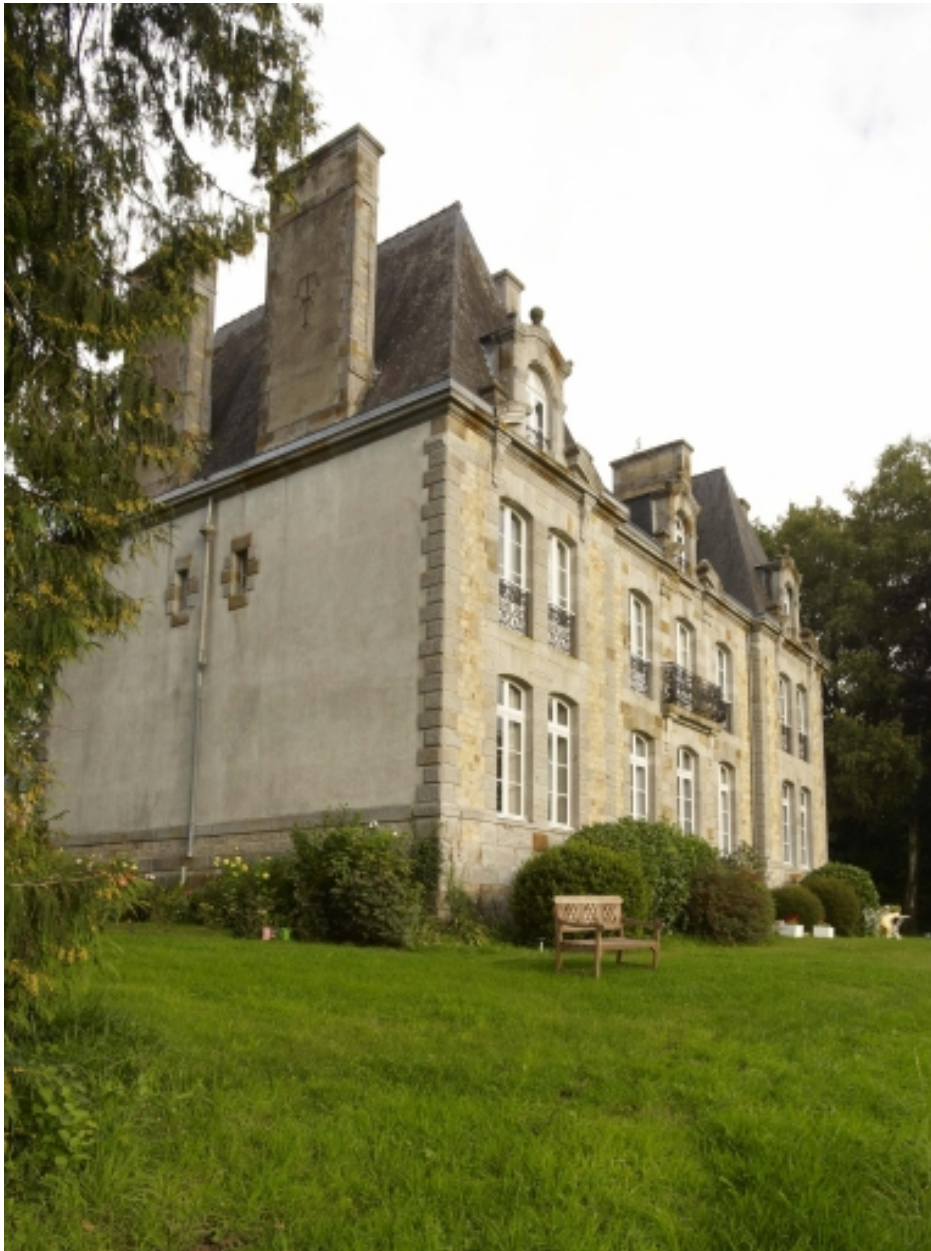
Elévation sud et pignon ouest
