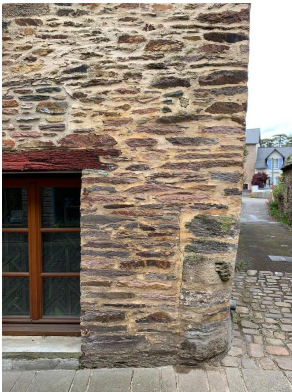
Façade nord. Rez-de-chaussée, partie est, pan coupé
