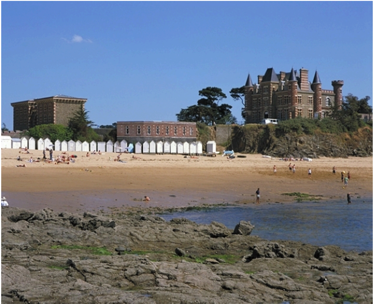
Vue de situation ouest
