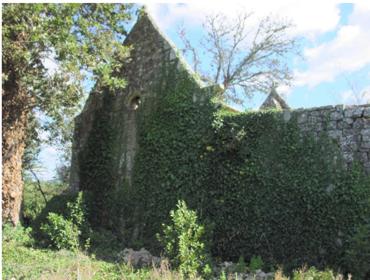
La chapelle, vue générale sud-ouest. A noter la forme du rampant d'origine du 15e siècle.
