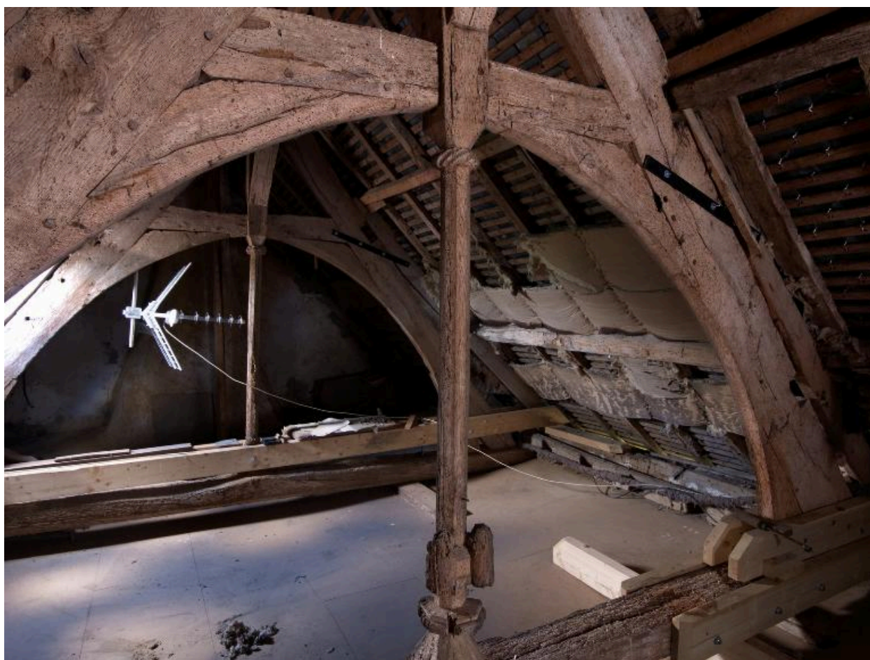
Ploubezre : manoir du Launay, charpente
